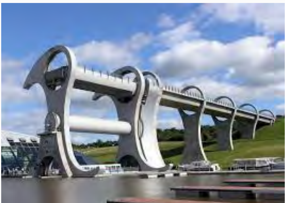
Båtar körs in i en övre och en nedre bassäng i "hjulet" varefter konstruktionen roteras ett halvt varv.
